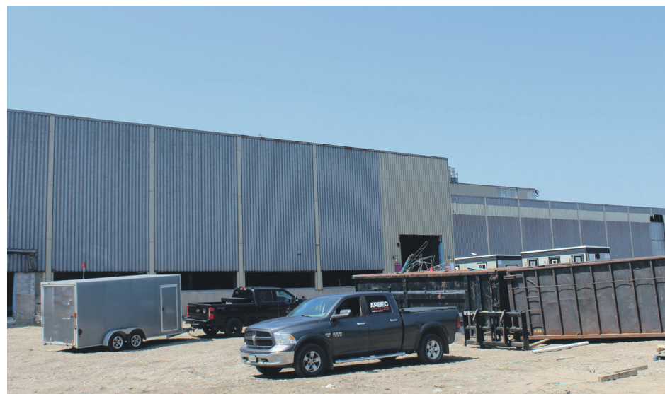
Des travaux sont en cours à l'ancienne usine de Rayonier Québec, afin qu'elle devienne une usine de biochar.
