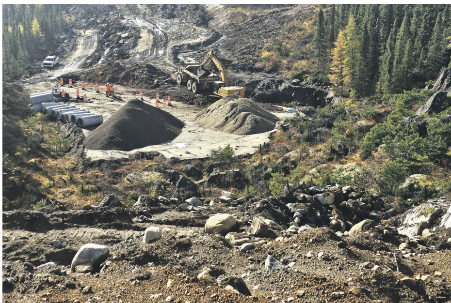
En 2023, une partie des travaux ont été effectués sur la route 389 entre Fire Lake et Fermont. Photo MTMD
