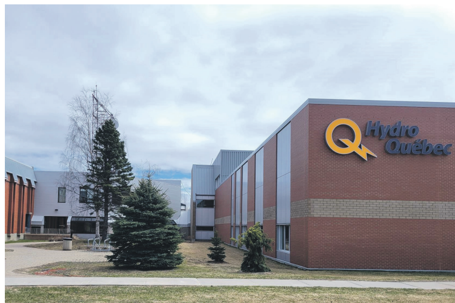
Vingt emplois du Centre de téléconduite d'Hydro-Québec de Baie-Comeau seraient menacés. Photo Anne-Sophie Paquet-T.
