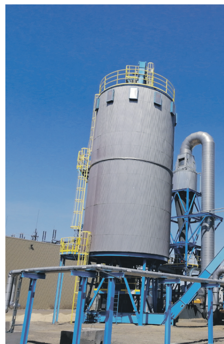
L'usine de biocarburant de Port-Cartier.
