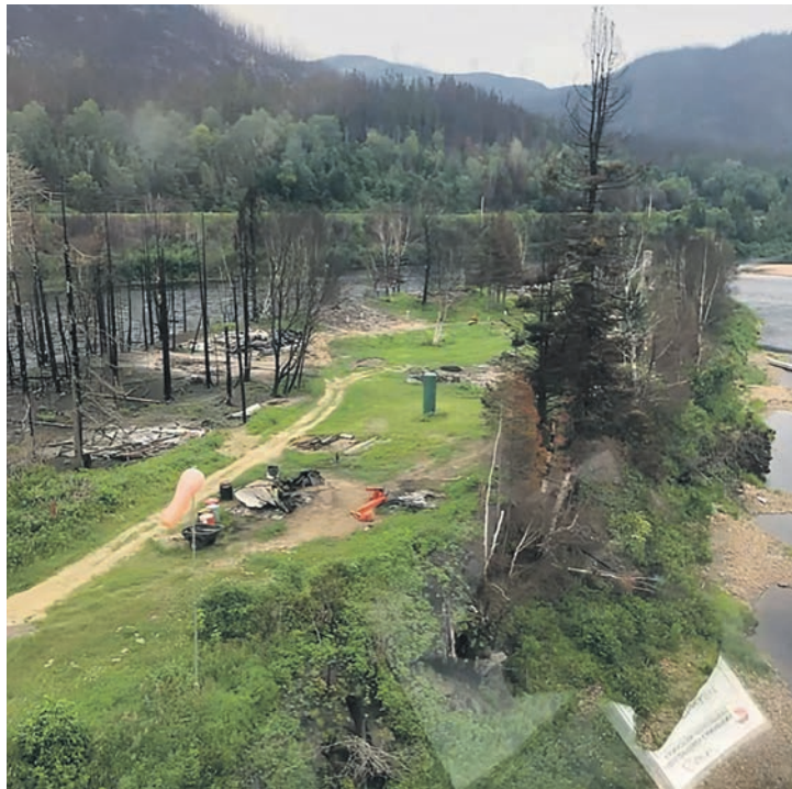
Les chalets de la Pourvoirie Moisie-Nipissis ont été rasés par les flammes en juin 2023. Photo Jimmy Mckenzie
