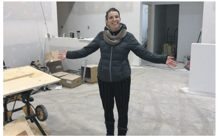
La directrice générale du CAB, Karoline Gilbert, au cœur du chantier des prochains locaux de l'organisme.
